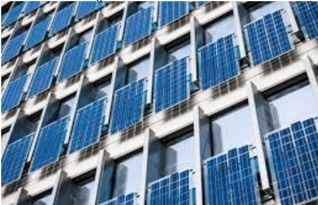
GreenBuilding | ENI CBC Med
